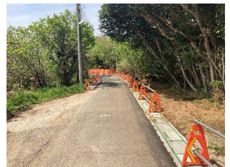
進捗途中の工事現場
